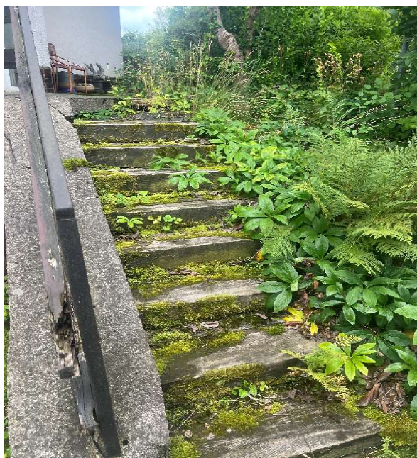
Dřevěné schodiště v exteriéru
