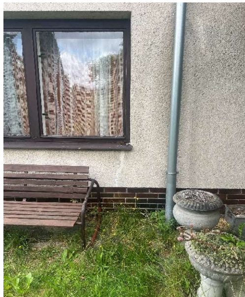
Trhlina v parapetu 1.NP
