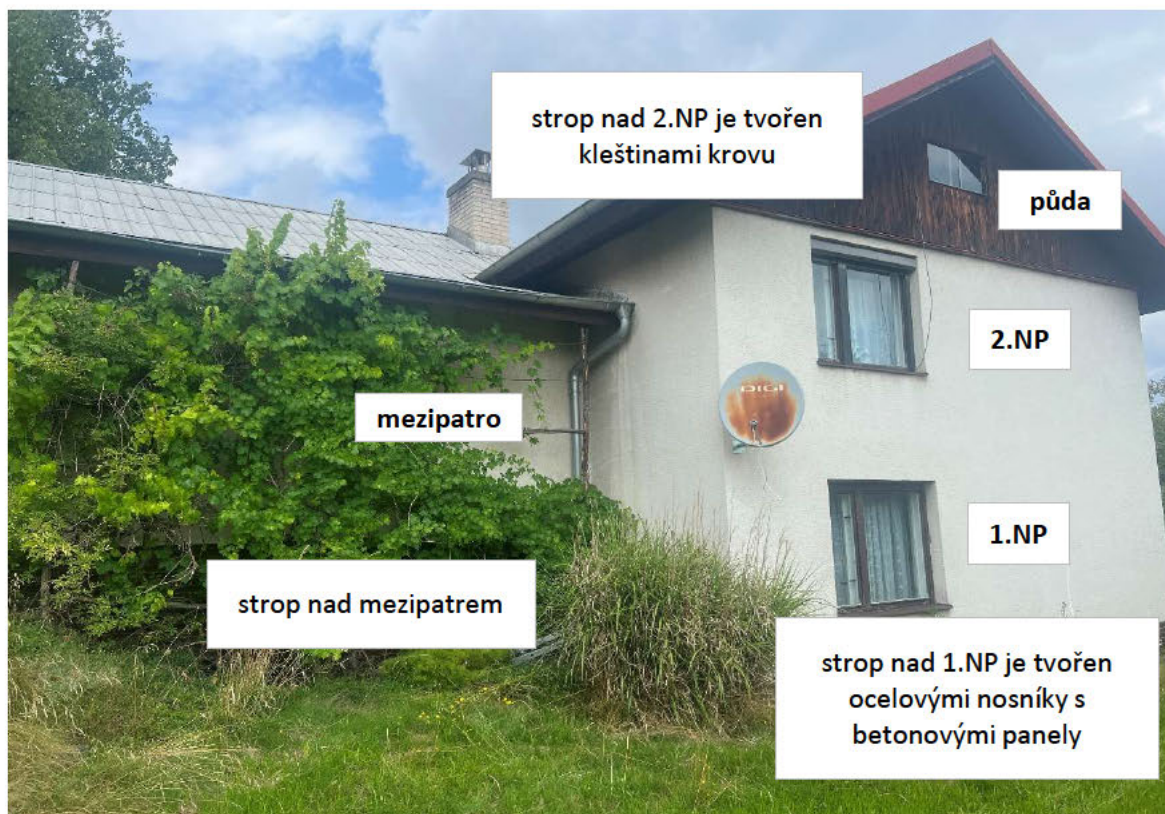
Pohled na objekt
