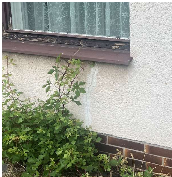
Trhlina v parapetu 1.NP
