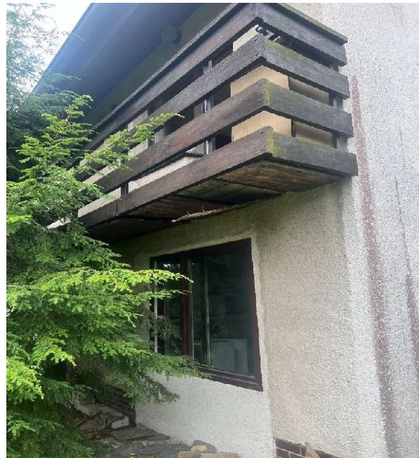
Pohled na balkon
